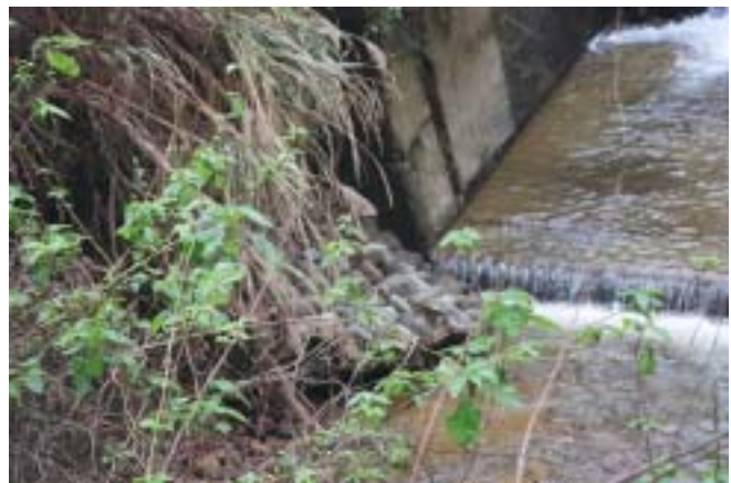
水路部分に一部崩壊が見られる
