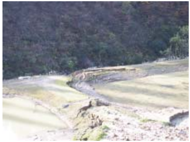
鯉の養殖池も多くが決壊して水漏れ
