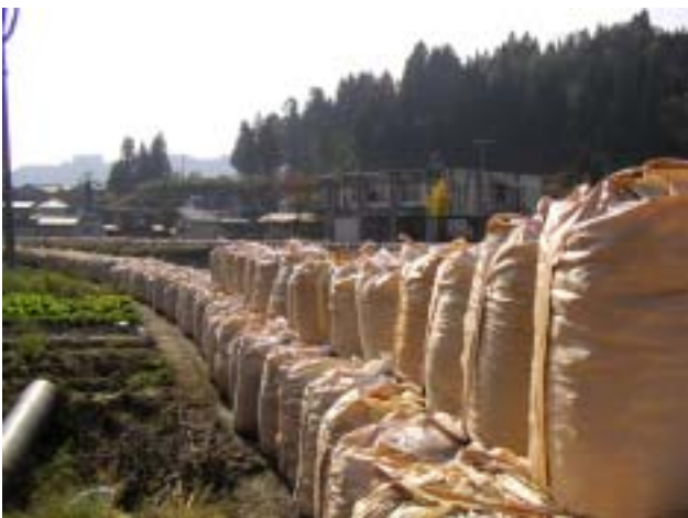
1 トン土嚢を堤防上に積み上げているが、土石流には不安である。 破損した取水堰
