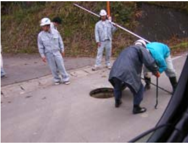
荒谷トンネルの手前では下水道の点検
