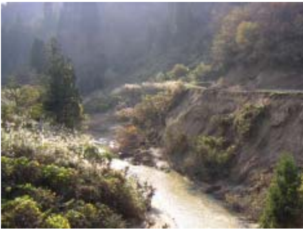
芋川の河岸はいたる所で崩壊している
