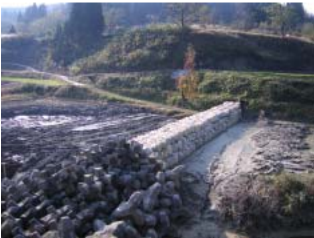
土石流対策のために築造した砂防ダム (河道内にブロックを積み、水田に土嚢を積む)
