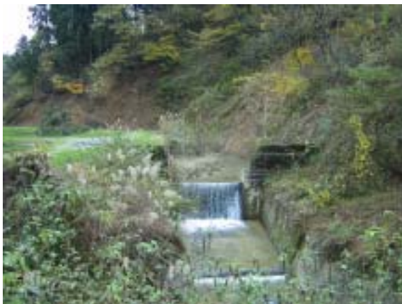
水路部分に一部崩壊が見られる
