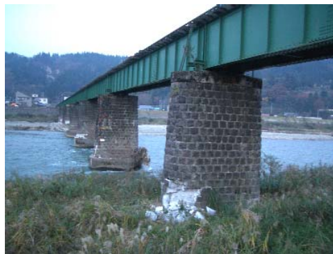
写真-17 中間橋脚基部のコンクリート（下流側の石積み）の崩落
