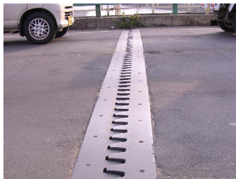
写真-30 フィンガージョイント部の段差
