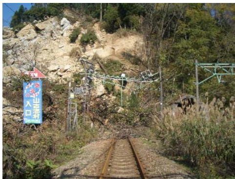
写真-28 トンネルの埋没
