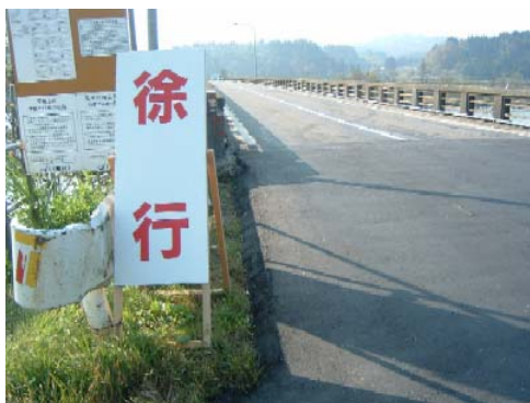
写真-4 橋台との境界部の段差の補修 その他，補強工事中（工事期間内に被災），など
