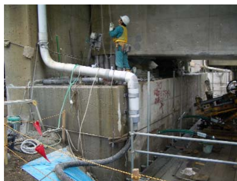
写真-44 橋台のアースアンカー補強 耐震補強工事中（工事期間内に被災），など
