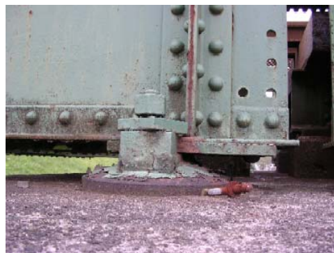
写真-60 桁移動
