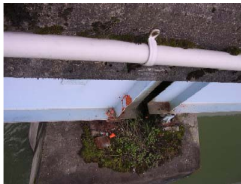
写真-36 中間橋脚上の支承部の破損・と鉛直補剛材の座屈変形
