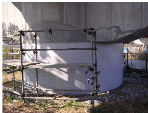
写真-23 RC 橋脚の補修状況
